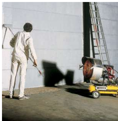
Bautrocknung und -beheizung im Winterbau
